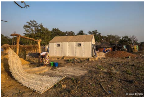
La construction d'un kiosque Better Shelter, initié par la Fondation IKEA. 2 cartons de 70 kg, un mode d'emploi et 6h de montage.
